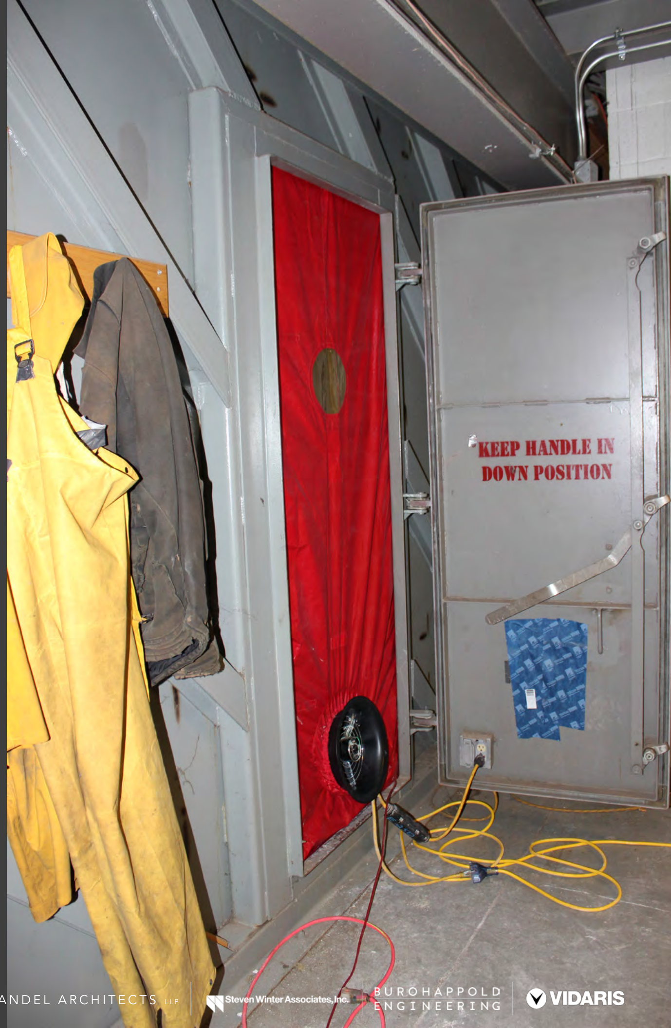
Blower Door Test Set-up
